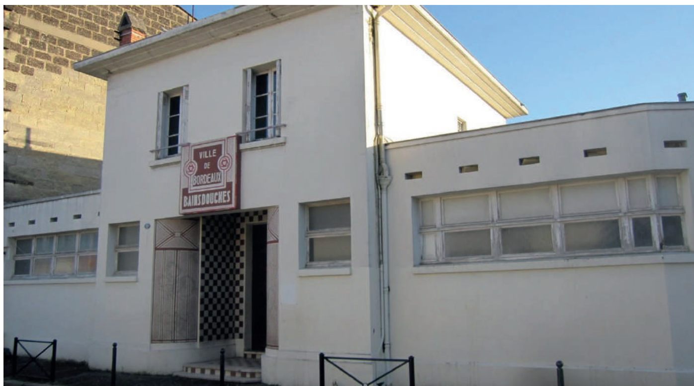
Figure 5 : Entrée des anciens bains-douches de Bastide
