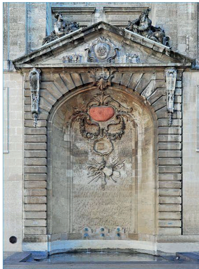
Figure 2 : Vestige de fontaine Place Saint-Projet
