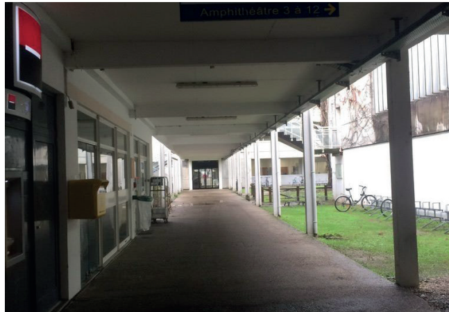
Etat existant des coursives
