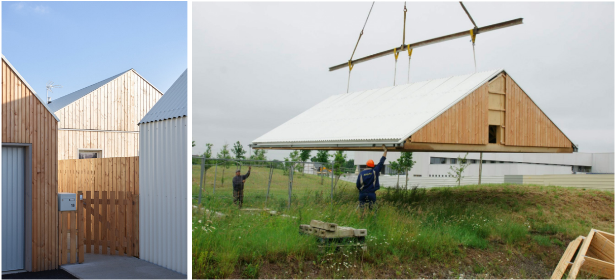
Fig 29 – Construction de 17 logements individuels sociaux à ossature bois à Ancenis, Habitat 44 et Agence Tetrarc architectes. (Source : site agence Tetrarc architectes)
