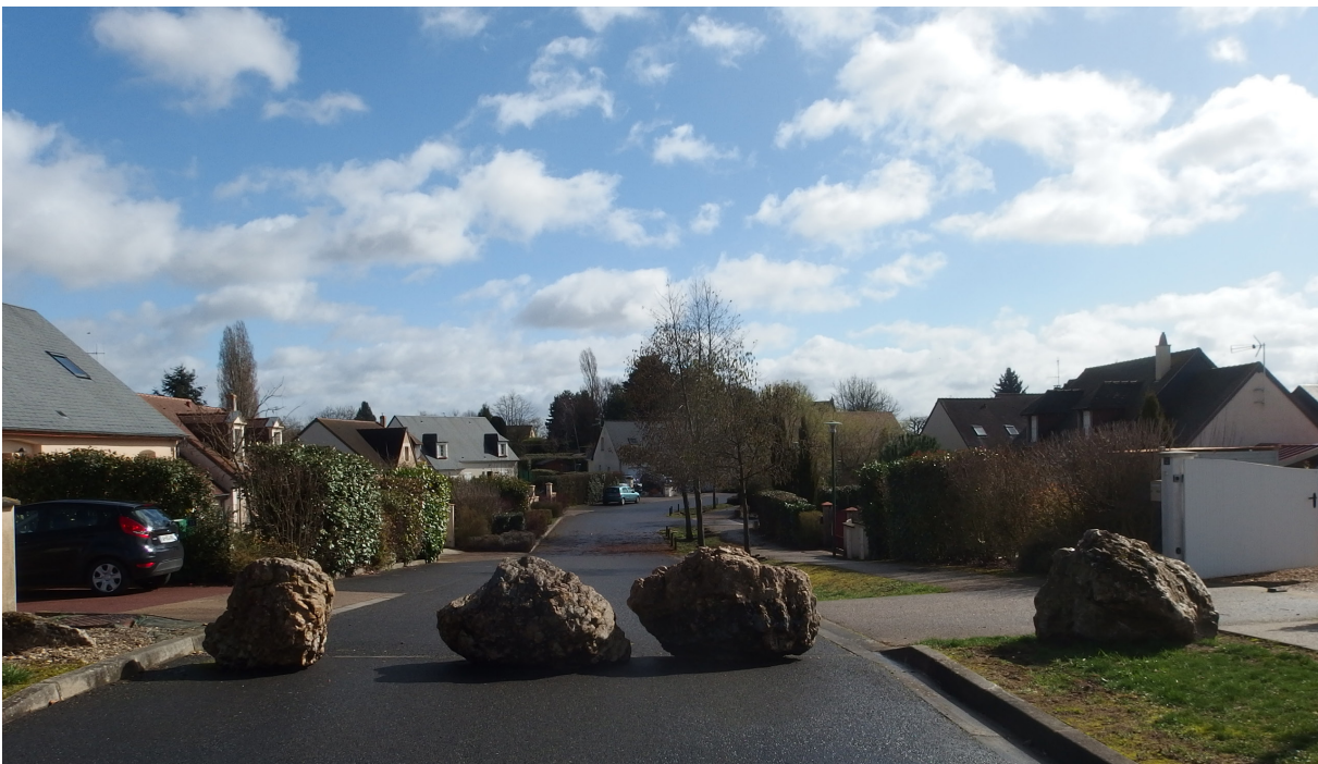
Fig 22 - Séparation Vallon 1 et 2 à Esvres
