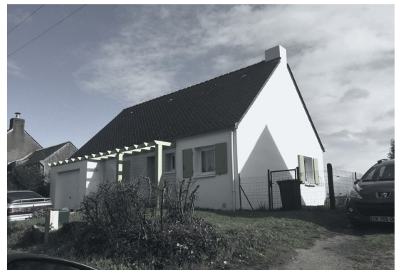
Fig 05 - Maison individuelle, Asserac (44)
