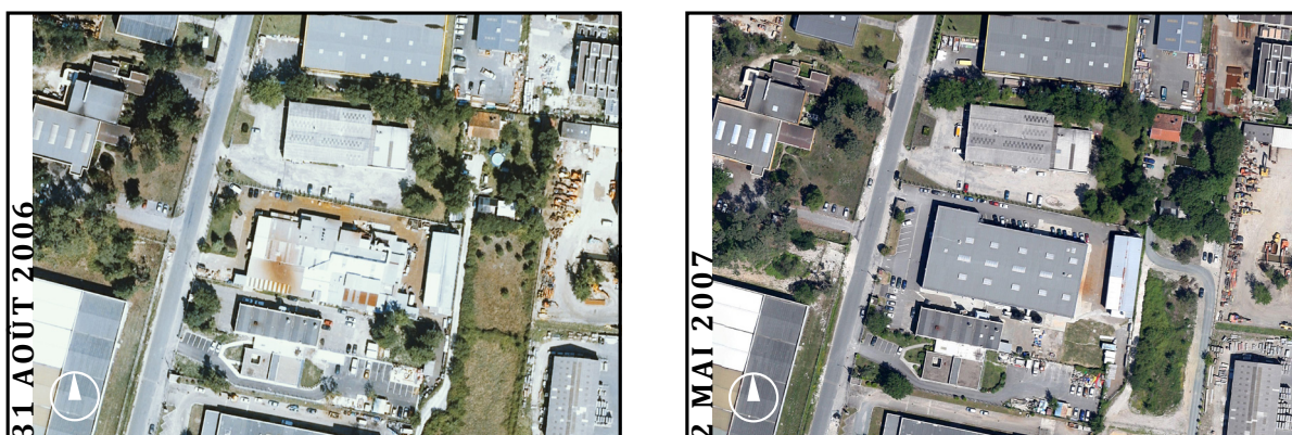
41 - Vues aériennes de l'entreprise Électrochrome (GoogleMaps)
