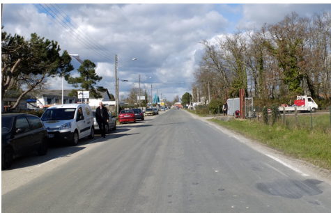
25 - Encombrement des voies
