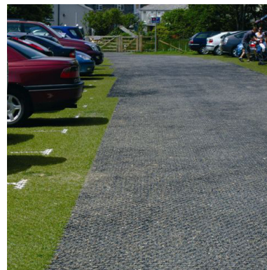
46 - exemple de mise en oeuvre de revêtement en gravier stabilisé par MCK ENVIRONNEMENT
