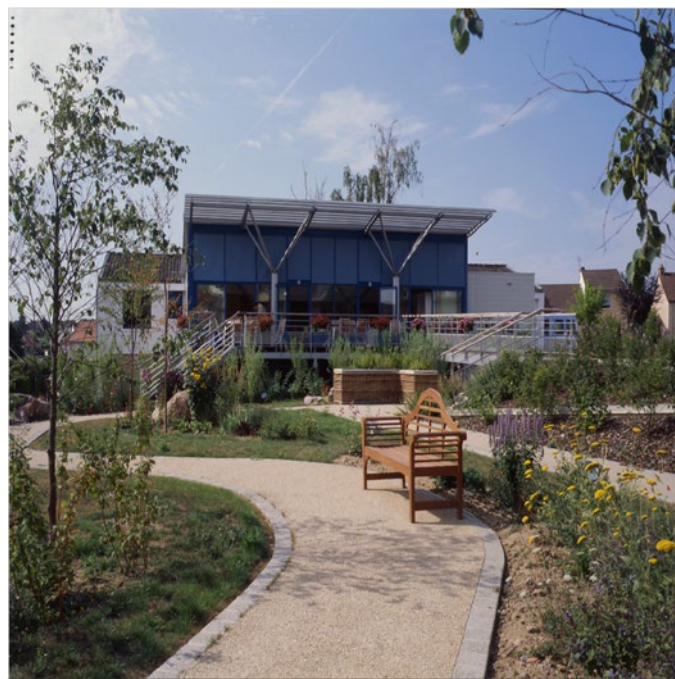
Fig 6 • Un jardin en accès libre est un élément qualitatif important ; un escalier thérapeutique conduit à la terrasse pour permettre des exercices avec les soignants. Accueil de jour 12 places, EHPAD du Creusot, Dehan et Spinga architectes. ©Ph.Dehan
