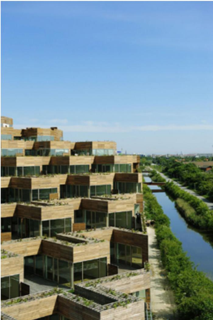
Dans ce projet, chacun des 80 appartements dispose d'une toiture bordée de parterres de fleurs surélevés formant des balustrades. Ce système en plus en d'être esthétique (plantes différentes en fonction des saisons), permet de bloquer les vues sur les appartements voisins et sur les niveaux inférieurs. Pour arroser automatiquement les bacs plantés, un système de récupération d'eau de pluie est intégré dans la construction.
