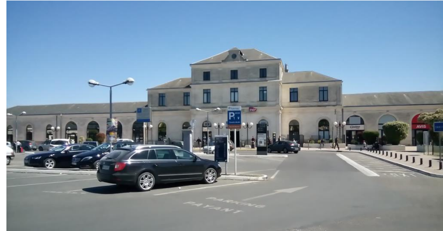
Fig. 19 : La gare de Libourne (le 21/04/17, R. Ballo)
